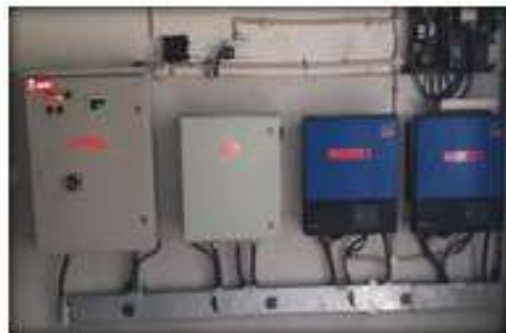
Solar Plant-Inverter Module
